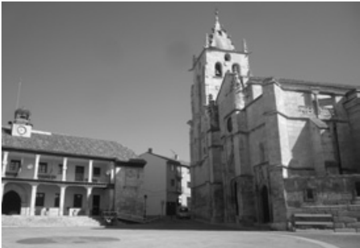
Place et église paroissiale de Torrelaguna
