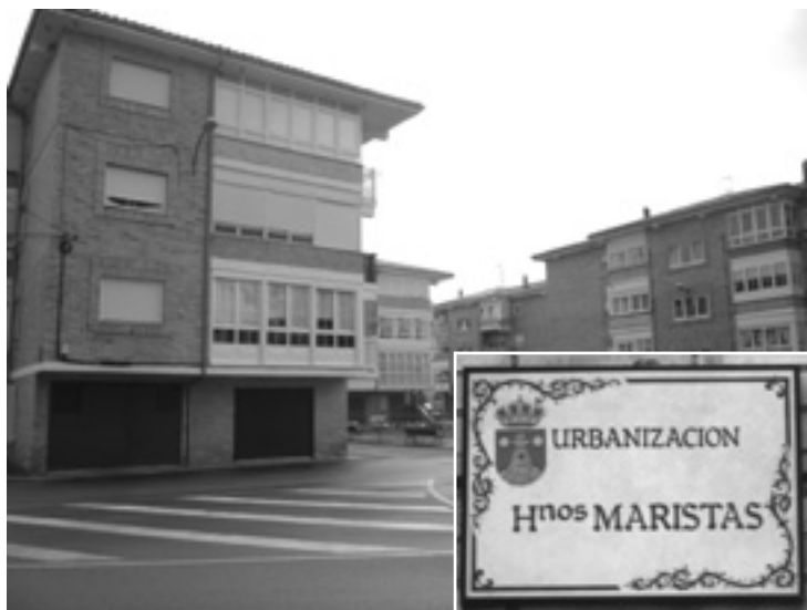
Cabezón de la Sal. A l'arrière du collège a été réalisée une urbanisation appelée le « Quartier des Frères Maristes ».
