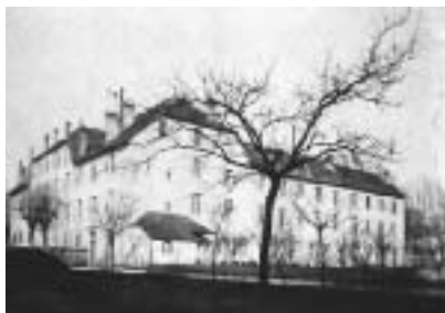
Vista da propriedade da Capucinière tomada do jardim. A eleição do Superior Geral Marista realizou-se neste edifício.
